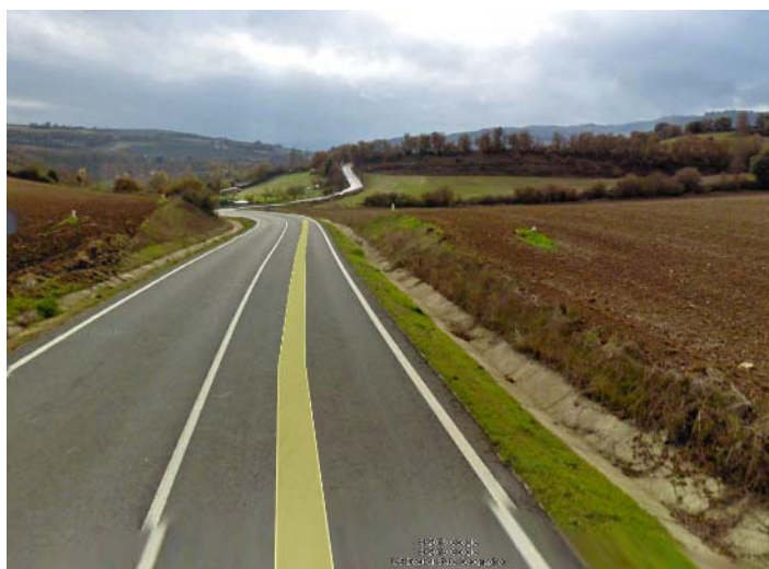
Imagen de la A-3310 en la zona donde se propone crear el nuevo acceso a la A-4342, en visual inversa. Se observa que la distancia de visibilidad en sentido sur es muy reducida, viéndose disminuida por la presencia de una curva con talud adyacente.
