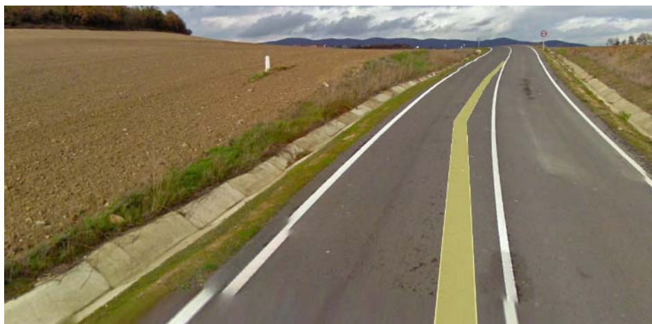
Imagen de la A-3310 en la zona donde se propone crear el nuevo acceso a la A-4342. Se observa que la distancia de visibilidad en sentido norte es muy reducida.
